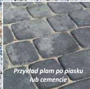
Niewłaściwe użycie cementu spowoduje nieodwracalne skutki estetyczne
